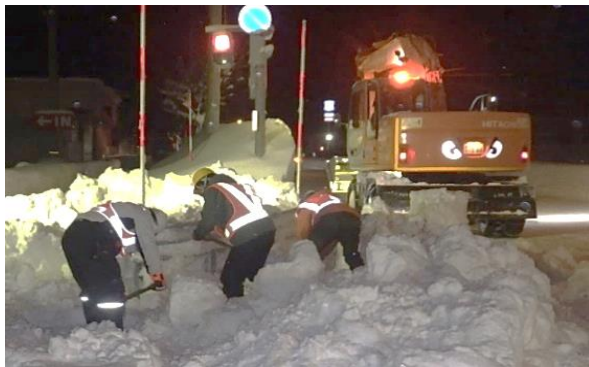
従前の手元作業員による手掘り作業
