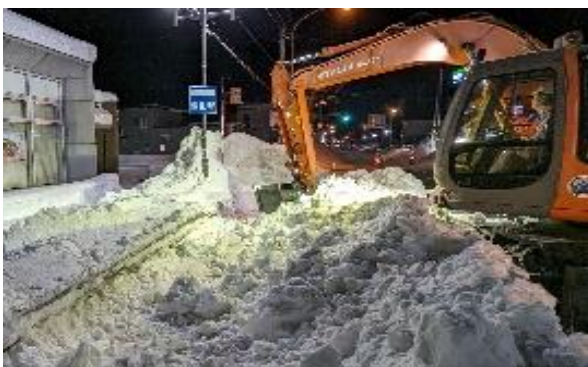
付属物に接触する事なく巻出し作業を実施
